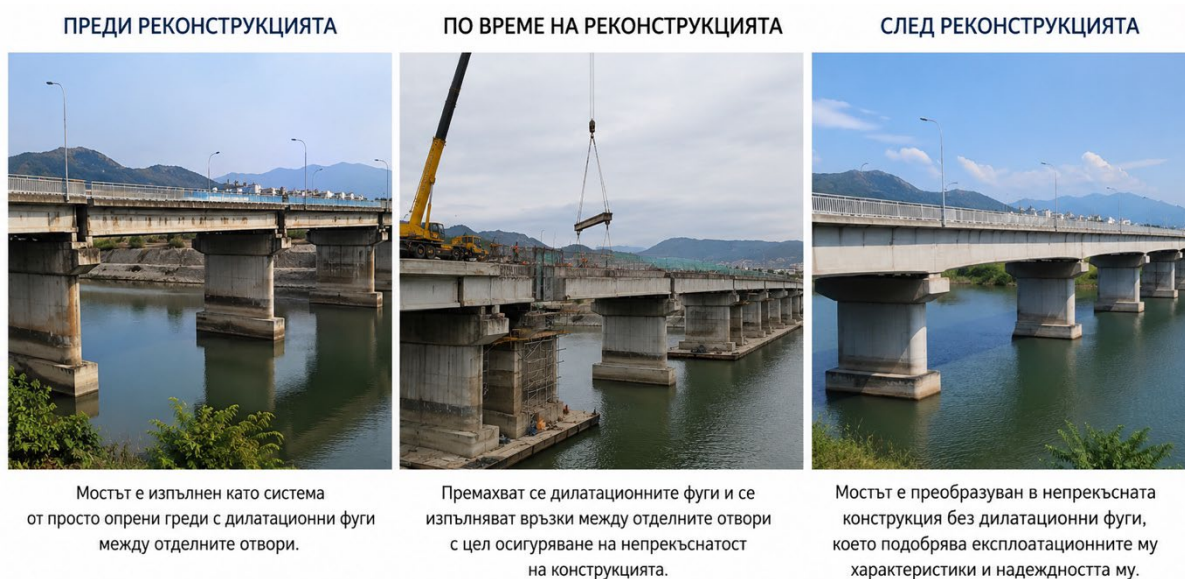
Фиг.5. Основни етапи при реконструкцията на мостова конструкция чрез премахване на дилатационните фуги и обединяване на отделните отвори в непрекъсната конструкция: а) преди реконструкцията; б) по време на реконструкцията; в) след реконструкцията
